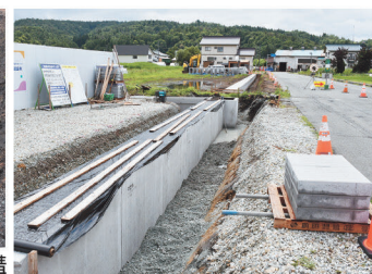
▲設置作業中の自由勾配側溝
