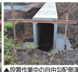
▲設置作業中の自由勾配側溝
