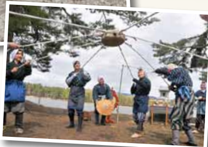
築堤工事で地面を固める「土搗き」の作業を再現
