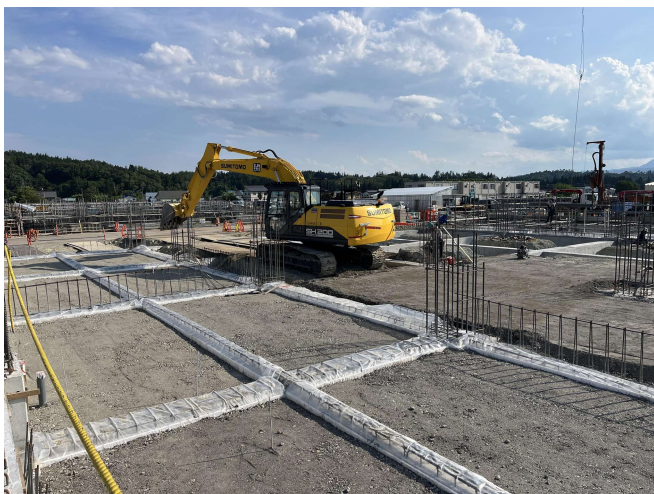
体育館棟の基礎コンクリートの打設が完了し、型枠を外したあと、埋め戻しを行います。
