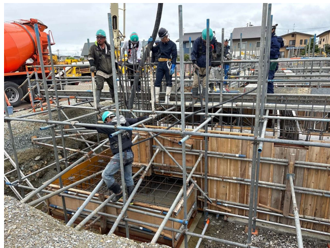
体育館棟の最終の工区の基礎コンクリートを打設しています。
