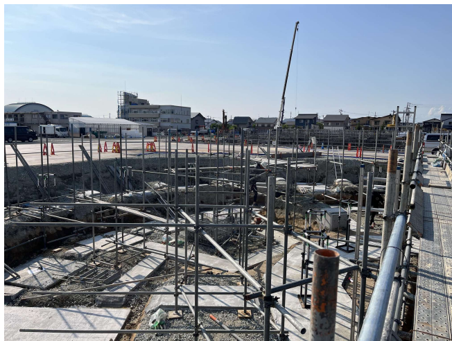
交流棟の基礎。交流棟は西側が円形の建物です。足場の組立ても手間がかかります。
