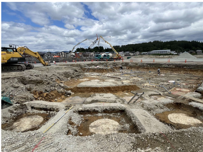
交流棟の基礎の掘削。交流棟の西側は半円形になっているので、掘削作業も手間がかかります。
