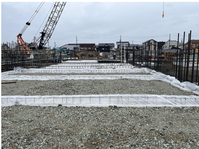
校舎棟の基礎。コンクリート打設が完了した所から土砂による埋め戻しを行います。
