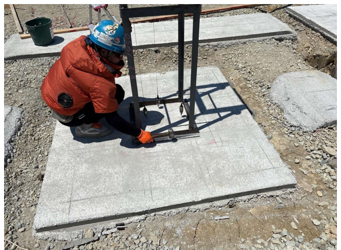
交流等の基礎。打設した基礎コンクリートに鉄骨柱のベースの位置を出し、鉄骨のボルトを設置します。
