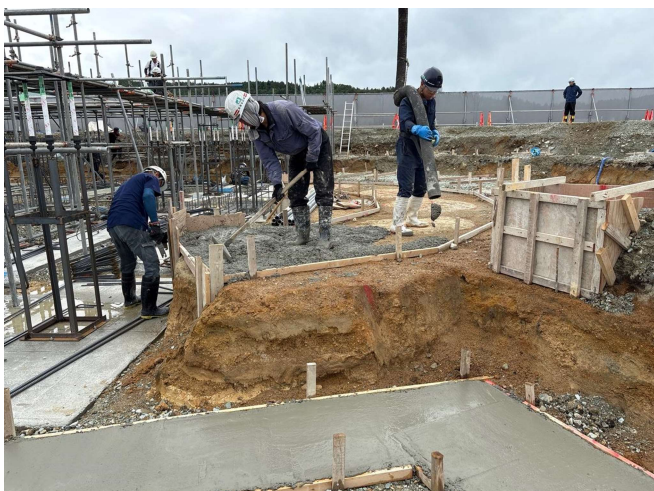
交流棟の基礎。円形部分の均しコンクリート打設も慎重に行います。
