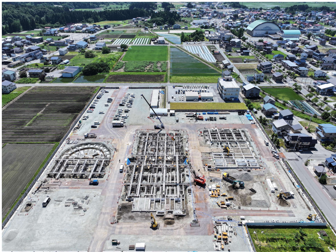
ドローンによる東側上空からの撮影。左側が交流棟、中央が校舎棟、右側が体育館棟です。 (令和8年6月24日撮影)
