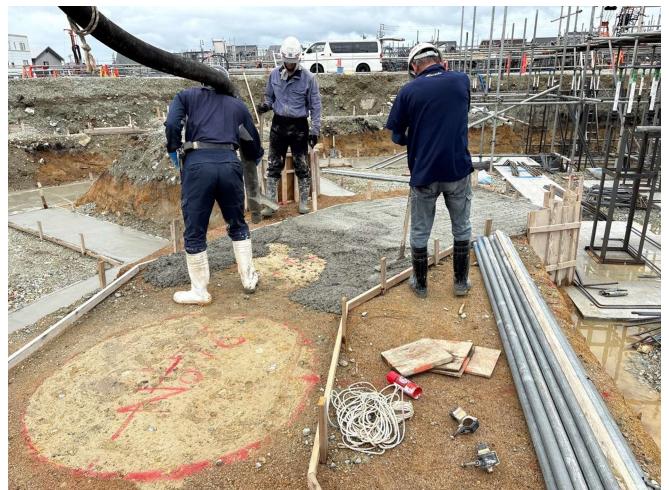
交流棟の基礎。地盤改良工事の施工確認（高さや位置のズレ）を行ってからコンクリートを打設します。
