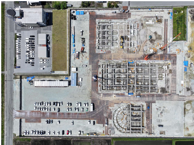
建設現場を上空から撮影。体育館棟の基礎と校舎棟2工区（5工区中）の基礎のコンクリート打設が完了しています。
