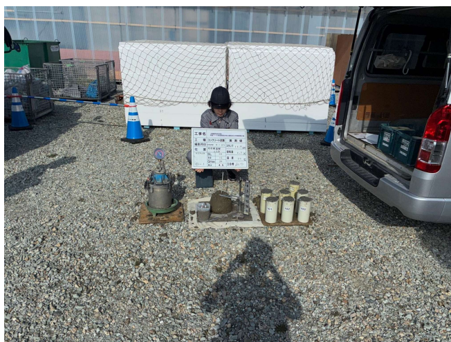
校舎棟の基礎。監理者（注）がコンクリートの品質を確認してから打設を行います。
