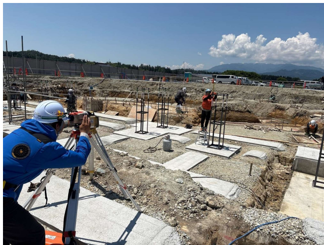
測量器で高さのチェックも行い、鉄骨柱のベース設置作業は完了です。
