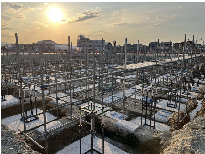
交流棟の基礎。作業員の通路足場を設置します。
