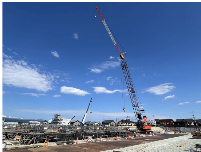
クレーンは資材の搬入で大忙しですが、事故のないよう慎重に作業を行います。
