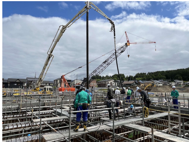
校舎棟の基礎。コンクリート打設は各担当約 20 人の作業員がチームプレイで慎重に行います。
