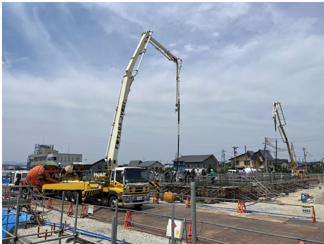
校舎棟の基礎。2台のポンプ車でコンクリートの打設を行っています。
