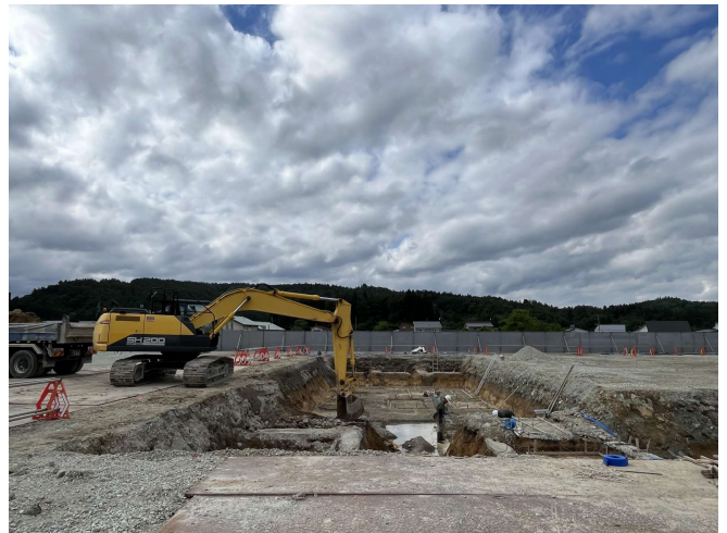
交流棟の基礎の掘削。交流棟もいよいよ掘削開始です。
