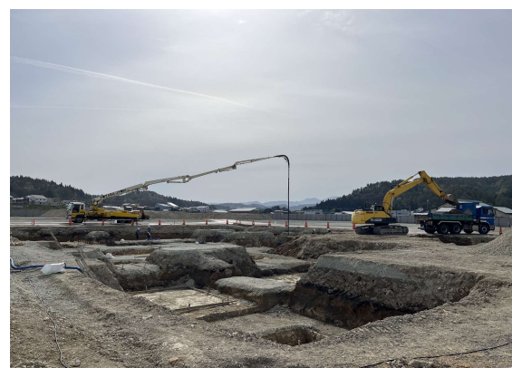
捨てコンクリート打設と並行して掘削作業も進めます。
