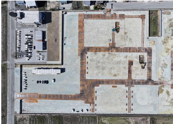
場内に1.5m×6.0mの鉄板を敷いて重機・車両の通路を整備しています。
