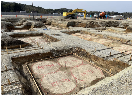
昨年に施工した地盤改良の跡が円形に見えています。これで建物を支えています。
