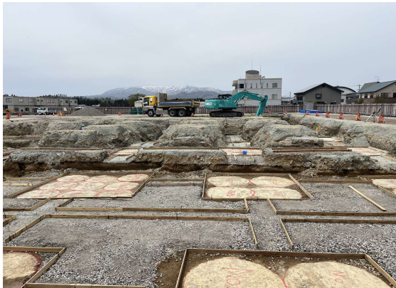
体育館棟の掘削状況。こちらでも地盤改良の跡が円形に見えています。体育館もしっかり支えます。
