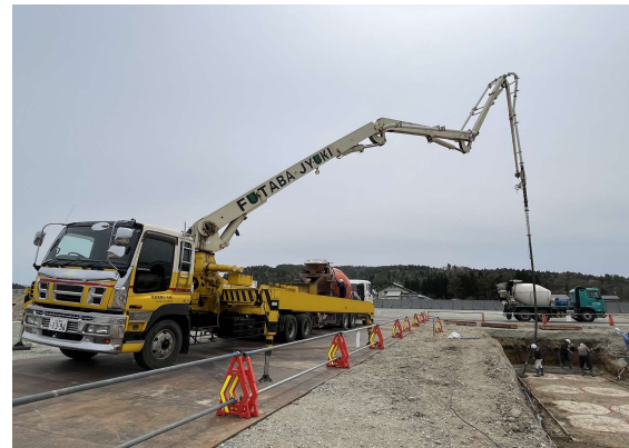
ならしコンクリート打設。コンクリートポンプ車は油圧シリンダの圧力でコンクリートを押し出す機械です。
