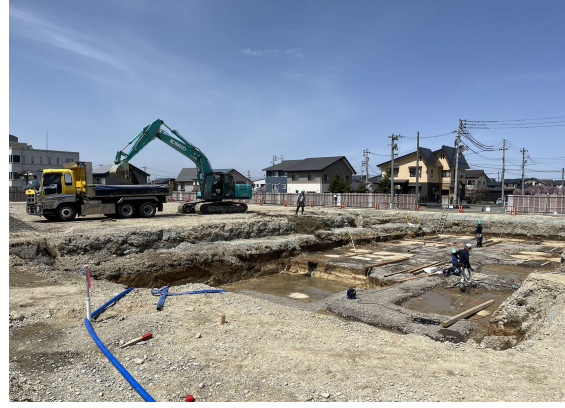
掘削により地下水が出てくるためポンプで排水しながら作業を行います。
