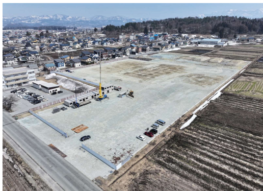
雪解け後の建設現場をドローンで空撮。
