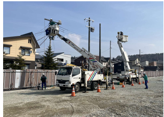
建設現場で使う電源の工事を行いました。
