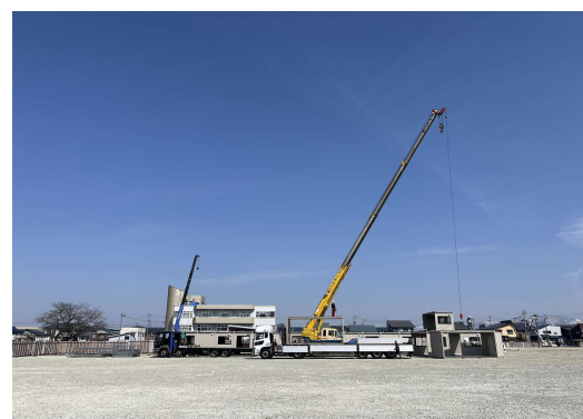
安全第一で作業を行っています。
