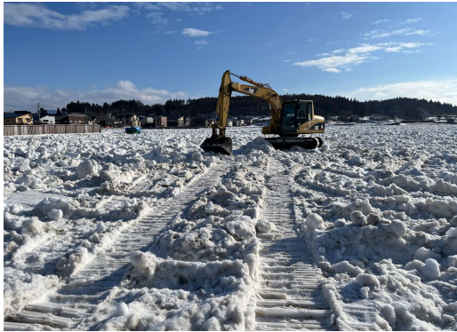
いよいよ活動再開。積雪も1m程度まで下がったので融雪促進のため重機で攪拌（かくはん）作業を行いました。
