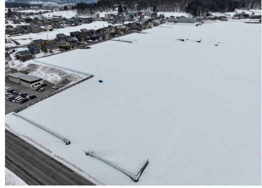
空撮による2月の建設現場の全景です。
