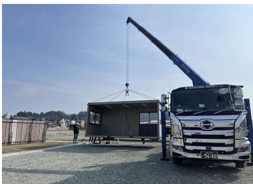
現場工事の拠点となる現場事務所の設置を開始！
