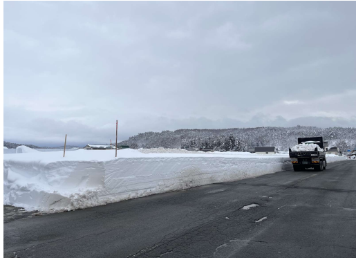
冬期休工中。高さ2mの仮囲いが雪に隠れています。
