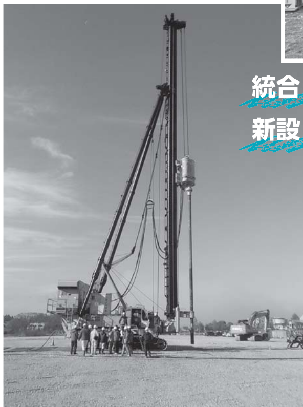
▲約25mもある巨大な機械を設置し、地盤改良工事が進められました
