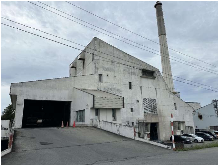
老朽化したごみ焼却施設の写真
