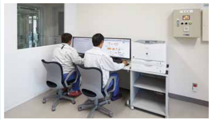
中央監視室兼作業員控室
