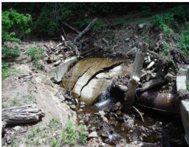
クラビコース登山道の土砂の崩落や倒木の影響により道路が崩落し、排水のヒューム管が露出している状況。
