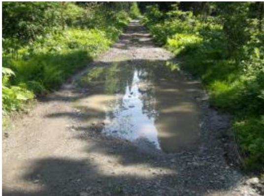
鶴子林道の破損・劣化状況。道路全幅で凹みがあり、車両の通行に支障がある状況。
