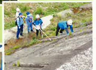
護岸にひび割れがないか確認中。→
