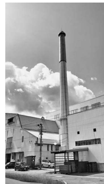
ごみ焼却処理施設
