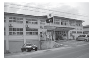
新築される現警察署
